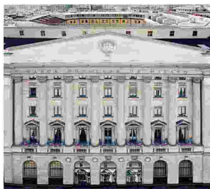
Banco BPM sede centrale di Milano
